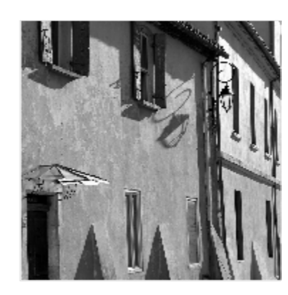
Alignement de façades
