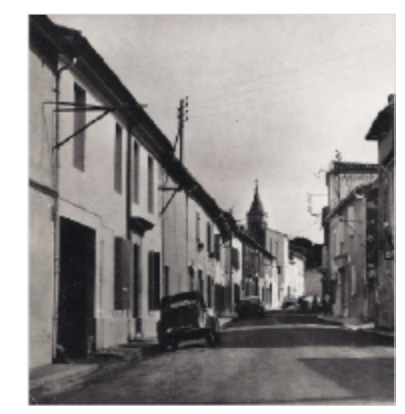
Alignement de façades
